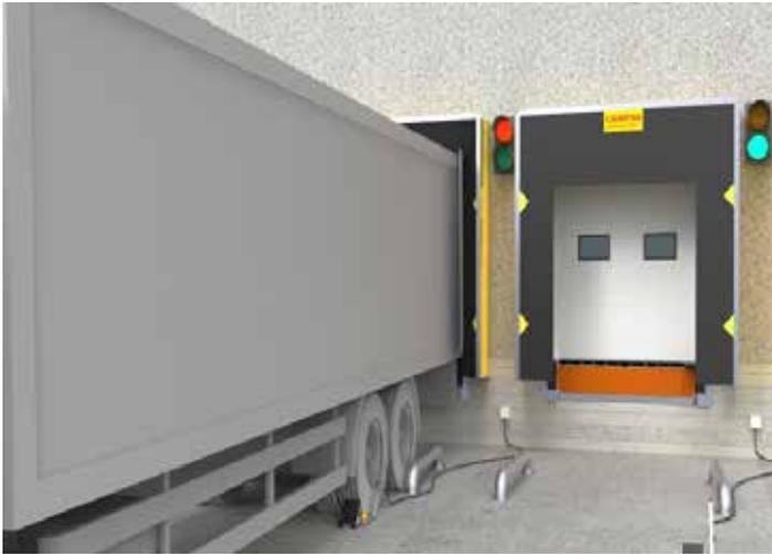
Système de commande **CTDS** pour la rétraction et le positionnement du véhicule
