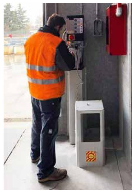
L'inspection routinière se réduit au simple contrôle du niveau de l'huile à l'intérieur de la Console positionnée à paroi à environ 1,5 m de hauteur du sol.
